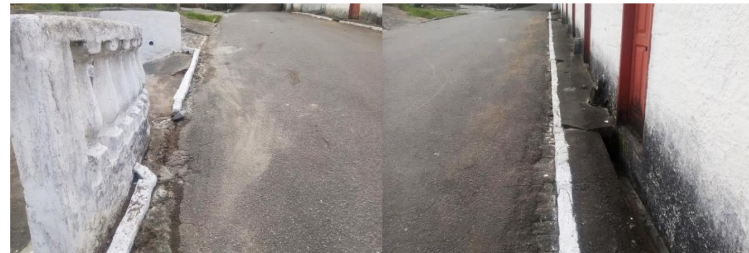
Calçada ao lado da Capela de Santo Aleixo
